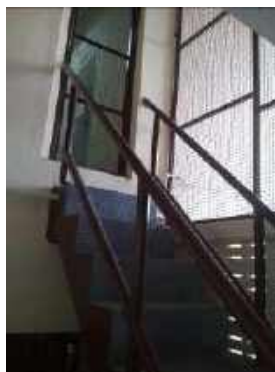
บันไดหนีไฟ
