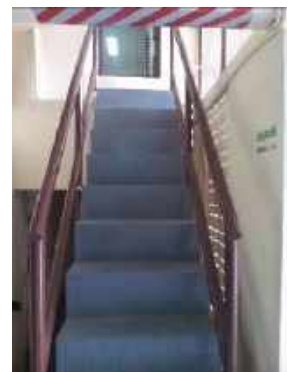
บันไดหนีไฟ อาคาร๒ชั้น๓กับอาคาร๓ชั้น๔
